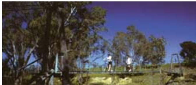
Axe Creek Swing Bridge
